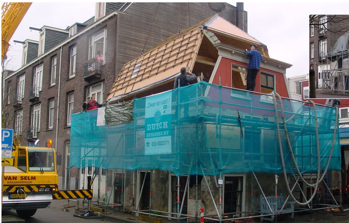
Foto boven en links: de kap van het Polderhuis werd in 2002 op maat gemaakt in Viersen, Duitsland, en ter plaatse in een week gemon-teerd en geplaatst. Er werd 16 cm Iso-floc in de houtcon-structie geblazen als isolatie.
