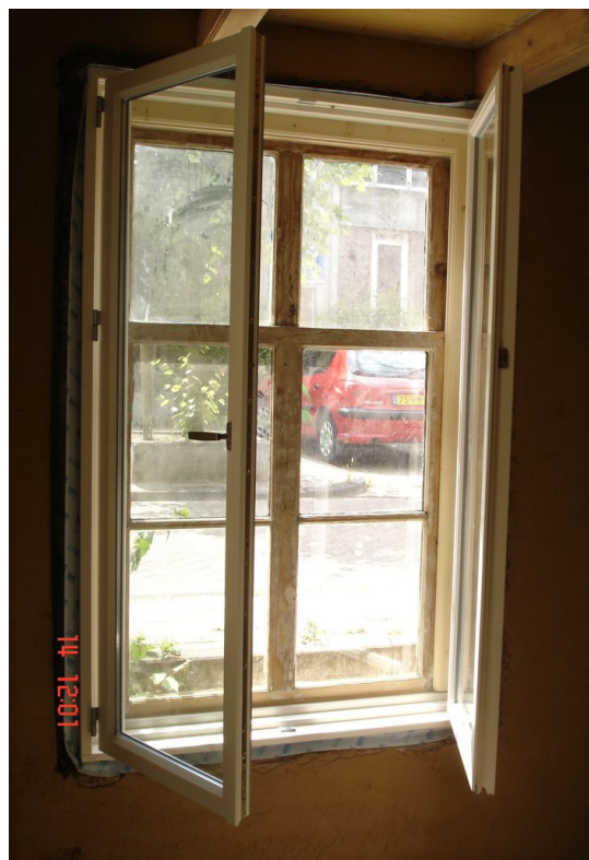
Foto boven: een compleet kozijn met HR ++ -glas achter de oude schuiframen.
